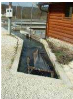
Mreža za uklanjanje lišća iz dovodnog kanala
