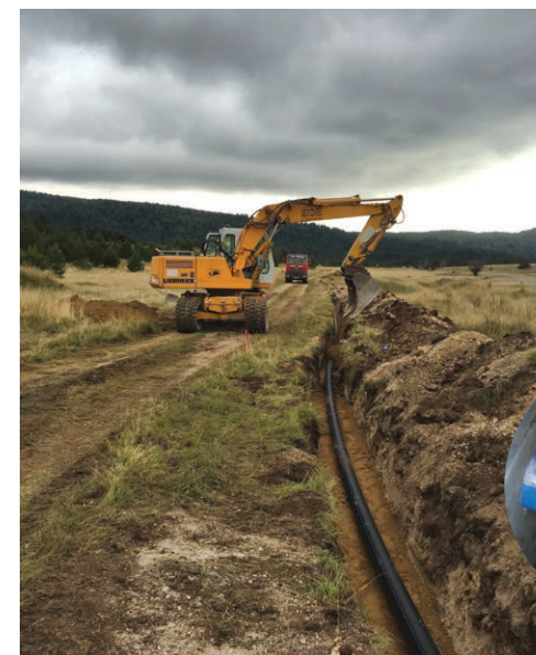
Izgradnja dovodno-distributivnog cjevovoda od novog rezervoara Vrščić do postojećeg glavnog gradskog rezervoara Gradina (HEIS, 2015)
